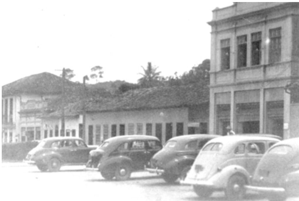
Foto06: Praça Tiradentes - À direita, em destaque o prédio onde funcionou o Cine Império (Cine Poeira). À esquerda, casario da época e parte do sobrado do Hotel Belo Horizonte. Automóveis da época estacionados. Teófilo Otoni. Ano: Final dos anos 50, do século XX. Procedência: Coleção de Wilmo Batista Pinto
