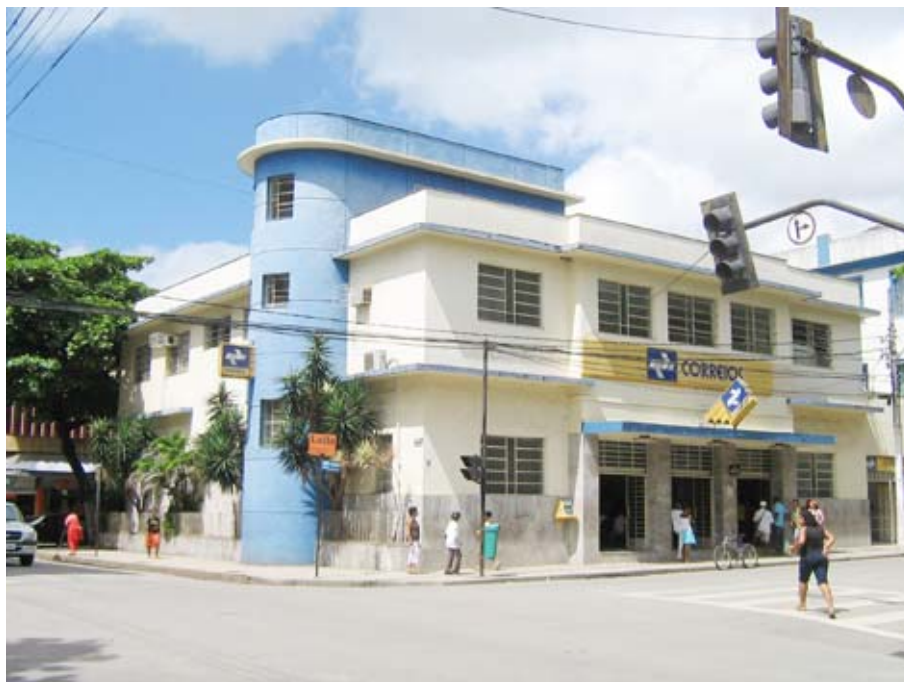
Foto68: Praça Tiradentes - Vista do edifício dos Correios à rua Engenheiro Antunes esquina com a Av. Getúlio Vargas. Teófilo Otoni. Ano: 2007. Fotógrafa: Karine Guimarães Berbari
