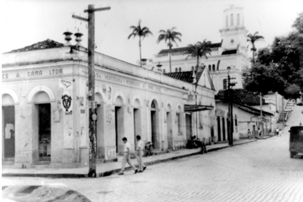
Foto05: Praça Tiradentes - A Casa Hertziana em imóvel construído pela Paróquia de Nossa Senhora da Conceição, onde funcionava a tipografia do jornal semanal A Família. Este imóvel foi demolido e em seu lugar edificado o prédio da Minas Caixa, hoje banco Credito. Ao fundo, a Catedral Imaculada Conceição. A primeira casa baixa à esquerda, na esquina da rua Dr. João Antônio, era a residência do dentista Nozinho Queiroga. Atualmente neste local está construído o Lancaster Palace Hotel. Teófilo Otoni. Ano: Final dos anos 50, do século XX. Procedência: Coleção de Márcio Graça Versiani
