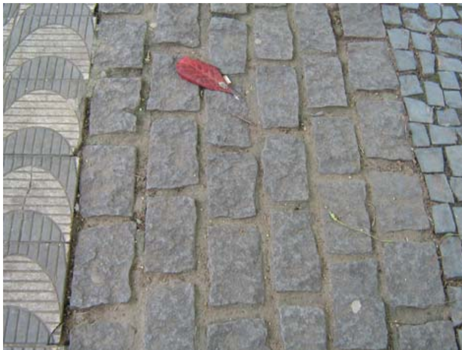
Foto73: Praça Tiradentes - Evidencia os diferentes tipos de materiais de piso, característico do lado esquerdo da praça(em relação ao sentido da Av. Getúlio Vargas). Apresenta da esquerda para a direita: piso em placa pré-fabricada de concreto; em seguida, piso em pedra cortada tipo paralelepípedo; e por fim, piso tipo pedra portuguesa. Teófilo Otoni. Ano:2007. Fotógrafa: Karine Guimarães Berbari
