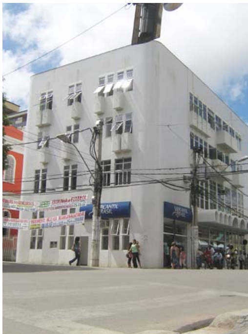
Foto12: Praça Tiradentes - Vista da edificação comercial do Banco Mercantil do Brasil à da rua Engenheiro Antunes esquina com Avenida Getúlio Vargas. Apresenta a poluição visual causada pela fiação e pelos cartazes fixados nos postes. Percebe-se a necessidade de pintura da faixa de travessia no asfalto. Teófilo Otoni. Ano:2007. Fotógrafa: Karine Guimarães Berbari
