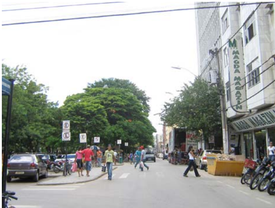
Foto23: Praça Tiradentes - Vista geral da rua Epaminondas Otoni à partir da rua Frei Gonzaga. As faixas de travessia devem ser repintadas. Há excesso de placas de sinalização. Teófilo Otoni. Ano:2007. Fotógrafa: Karine Guimarães Berbari
