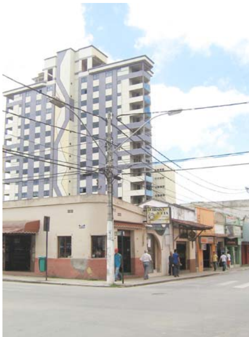
Foto11: Praça Tiradentes - Vista da edificação comercial à esquina da rua Engenheiro Antunes esquina com rua Dr. Reinaldo. Apresenta o estado ruim de conservação da mesma que necessita de reparos e pintura. Ao fundo a verticalização de altura inadequada para a região. Percebe-se a necessidade de pintura da faixa de travessia no asfalto. Teófilo Otoni. Ano:2007. Fotógrafa: Karine Guimarães Berbari
