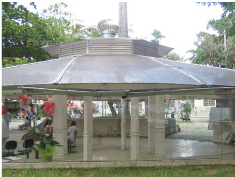
Foto50: Praça Tiradentes - Vista do Espaço Cultural (antigo Caramanchão). Evidencia: o formato octogonal deste espaço(com estrutura de madeira, vedações laterais em vidro e cobertura translúcida em material tipo policarbonato), que encontra-se em bom estado geral. Apresenta necessidade de reparos na sua cobertura e principalmente na calha. Há necessidade de reparos internos principalmente na alvenaria que cerca os canteiros, pois a mesma apresenta descascamento devido à infiltração. Teófilo Otoni. Ano:2007. Fotógrafa: Karine Guimarães Berbari
