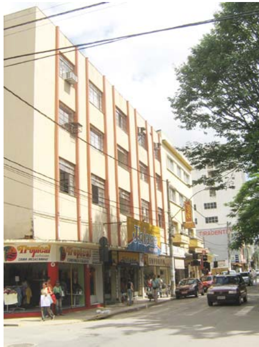
Foto15: Praça Tiradentes - Vista dos edifícios de uso misto na rua Epaminondas Otoni esquina com a rua Engenheiro Antunes. Apresenta a poluição visual causada pela variedade de tipos e cores de placas fixadas nas fachadas e pelo excesso de quantidade das mesmas. Há deposição inadequado de lixo ensacado sobre os passeios. A faixa de travessia deve ser repintada. Teófilo Otoni. Ano:2007. Fotógrafa: Karine Guimarães Berbari
