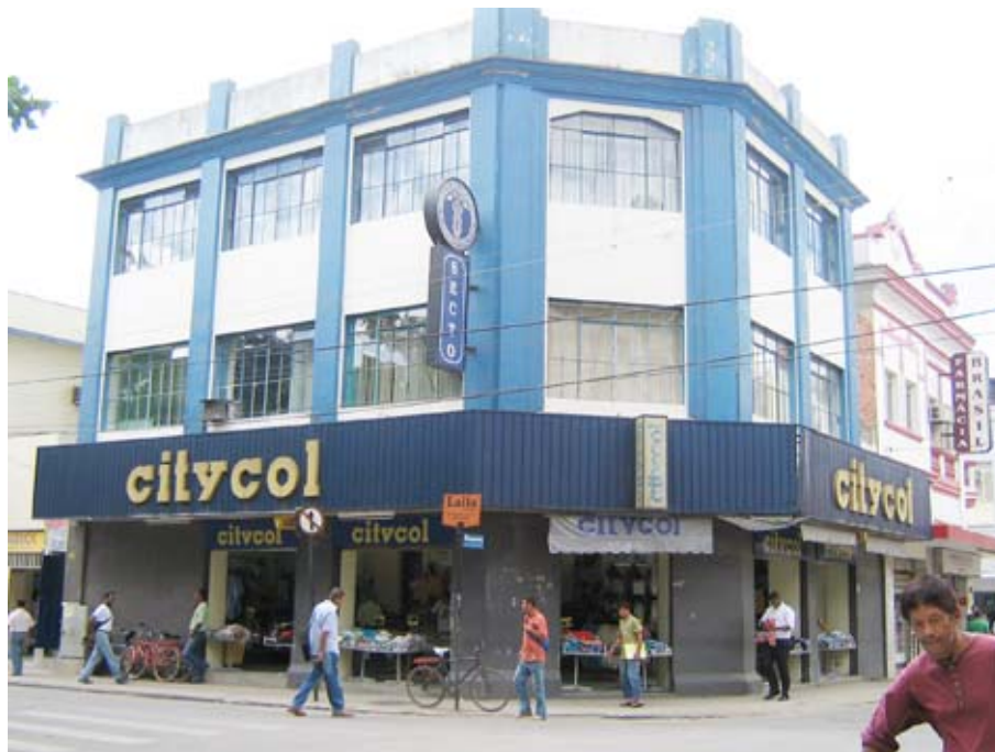
Foto14: Praça Tiradentes - Vista da edificação comercial Citycol na esquina da rua Engenheiro Antunes com a rua Epaminondas Otoni. Apresenta a poluição visual da fachada causada pelo excesso de placas, estacionamento inadequado de bicicletas. Há necessidade de pintura e manutenção das fachadas tanto da edificação evidente quanto da que está ao seu lado, com frisos vermelhos. A faixa de travessia deve ser repintada. Teófilo Otoni. Ano:2007. Fotógrafa: Karine Guimarães Berbari
