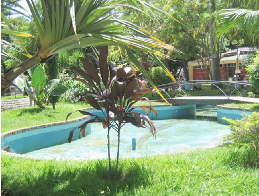
Foto57: Praça Tiradentes - Vista do Lago Artificial. Evidencia o resultado estético-visual do Lago, seu estado de conservação ruim e a ambientação que o mesmo proporciona junto aos outros elementos de seu entorno. Há necessidade de reparos e manutenção, principalmente no interior, piso e laterais necessitam de pintura e limpeza. O jardim está bem cuidado porém há necessidade de podas. Teófilo Otoni. Ano:2007. Fotógrafa: Karine Guimarães Berbari
