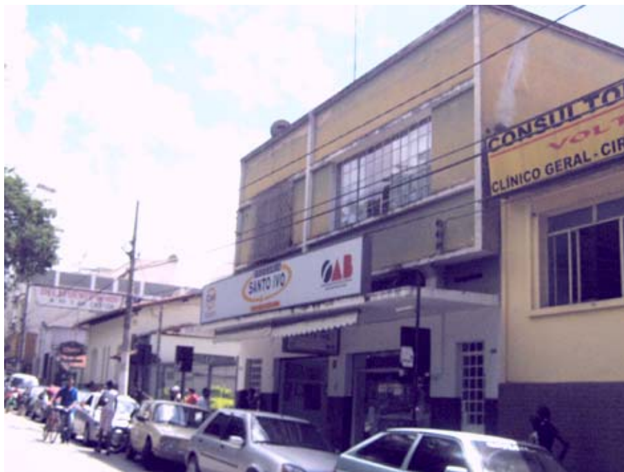
Foto20: Praça Tiradentes - Vista das fachadas de edificações de uso misto à rua Dr. Reinaldo. Apresenta a poluição visual causada pela fiação pública e letreiros de propaganda. Há necessidade de requalificação e pintura da fachada da edificação em evidência (na cor amarela). Teófilo Otoni. Ano:2007. Fotógrafa: Karine Guimarães Berbari
