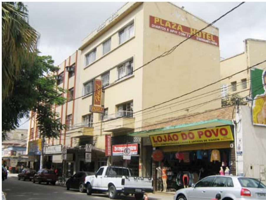
Foto16: Praça Tiradentes - Vista dos edifícios de uso misto na rua Epaminondas Otoni à partir da praça. Apresenta a poluição visual causada pela variedade de tipos e cores de placas fixadas nas fachadas e pelo excesso de quantidade das mesmas. Apresenta a poluição visual causada pela fiação pública. Mostra parte de outdoor (lado direito da foto) fixado na lateral do muro de divisa que está voltado para o Cine Palácio, desvalorizando a visão do conjunto. Teófilo Otoni. Ano:2007. Fotógrafa: Karine Guimarães Berbari
