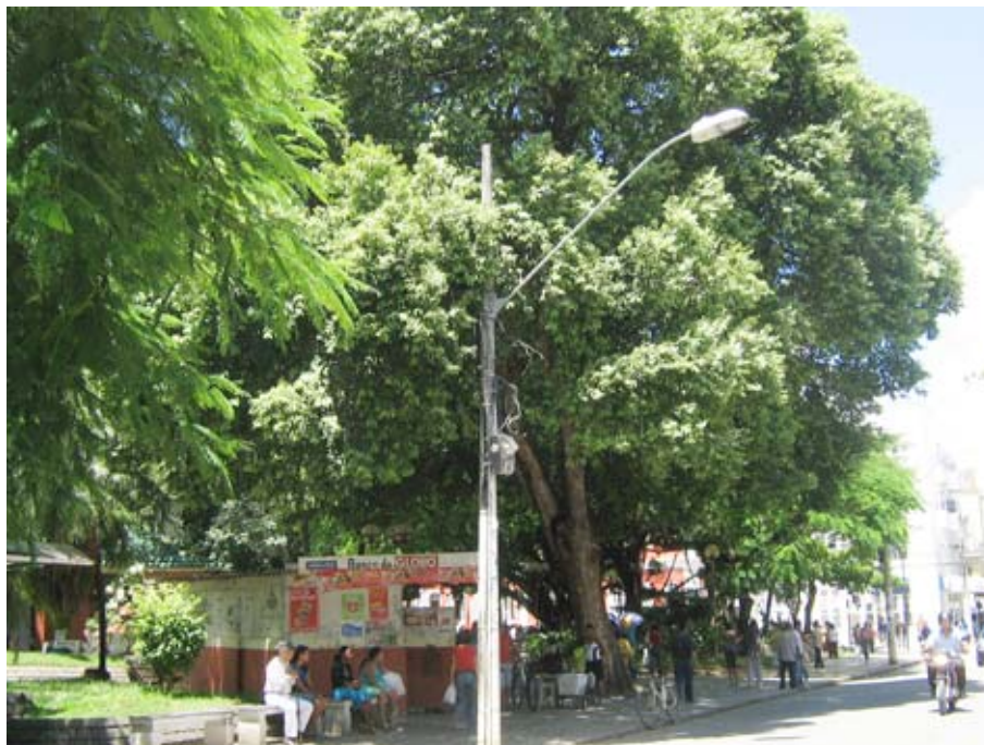
Foto31: Praça Tiradentes - Vista da banca à partir da Av. Getúlio Vargas. Mostra a tipologia formal e volumétrica das bancas existentes na praça, no caso, evidencia a instalação degradante da banca sobre o canteiro. Mostra o tipo de iluminação pública existente nas vias. Teófilo Otoni. Ano:2007. Fotógrafa: Karine Guimarães Berbari
