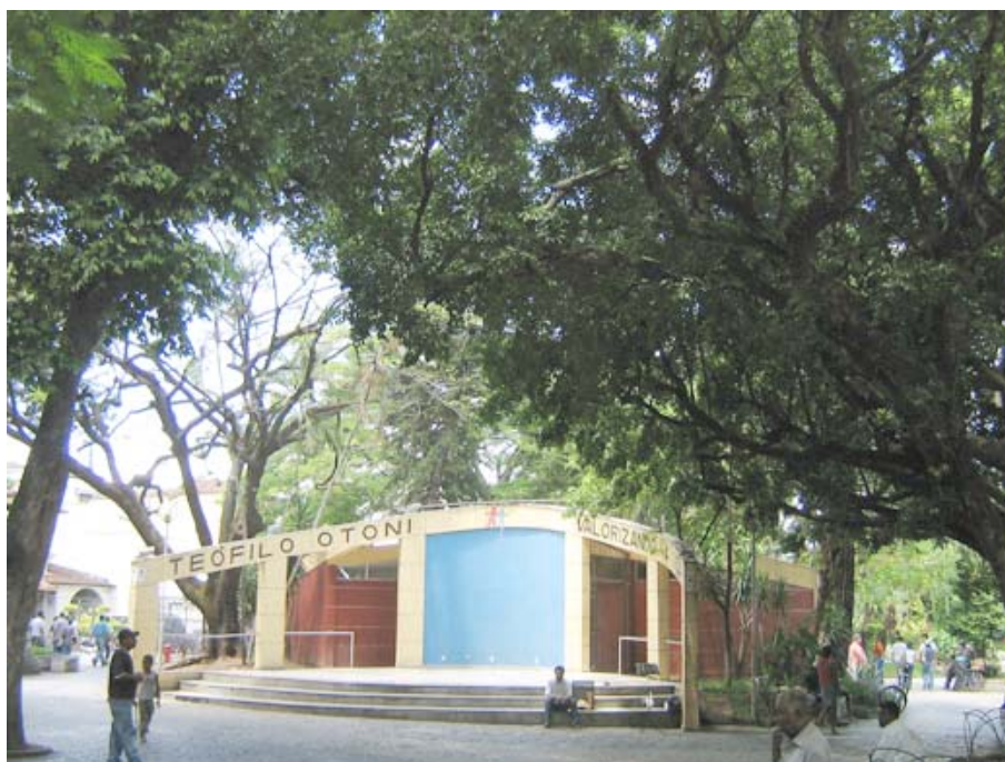
Foto46: Praça Tiradentes - Vista do Anfiteatro à partir do largo à frente do mesmo, situado no lado direito em relação ao sentido da Av. Getúlio Vargas. Mostra a tipologia formal e volumétrica desta edificação, sendo que a mesma apresenta-se em bom estado. Teófilo Otoni. Ano:2007. Fotógrafa: Karine Guimarães Berbari
