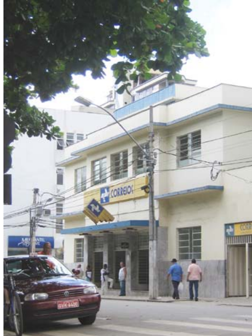
Foto13: Praça Tiradentes - Vista da edificação comercial dos Correios à da rua Engenheiro Antunes a partir da esquina com rua Epaminondas Otoni. Apresenta a poluição visual causada pela fiação. Percebe-se a necessidade de pintura da faixa de travessia no asfalto. Teófilo Otoni. Ano:2007. Fotógrafa: Karine Guimarães Berbari
