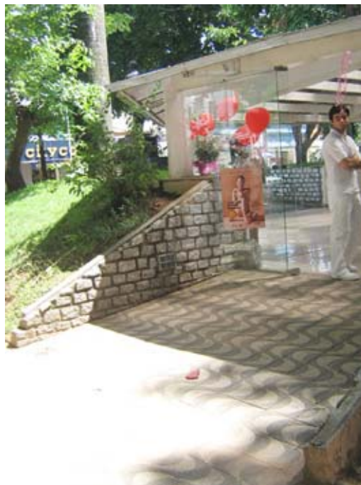
Foto51: Praça Tiradentes - Vista do Espaço Cultural e seu acesso pelo lado voltado para a Av. Getúlio Vargas. Evidencia: o vidro de vedação lateral e aperta; o material do piso e da mureta de cercamento do jardim. Apresenta necessidade de reconstituição de algumas partes da mureta e recuperação do gramado. Teófilo Otoni. Ano:2007. Fotógrafa: Karine Guimarães Berbari
