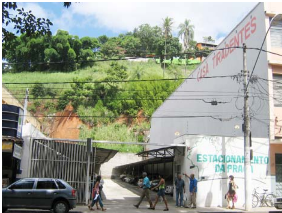
Foto18: Praça Tiradentes - Vista da fachada do Estacionamento da Praça à rua Epaminondas Otoni à partir da praça. Apresenta a poluição visual causada pela fiação pública, pinturas de propagandas. Há necessidade de requalificação da fachada. Teófilo Otoni. Ano:2007. Fotógrafa: Karine Guimarães Berbari
