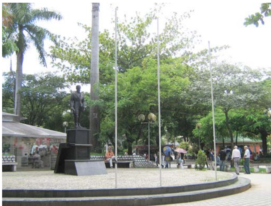
Foto52: Praça Tiradentes - Evidencia o elevado aonde está fixada a estátua de Theóphilo Benedicto Ottoni, acessível por dois degraus de escada, sendo que esta apresenta necessidade de reconstituição em alguns pontos onde a cerâmica do piso encontra-se quebrada. A estátua encontra-se em ótimo estado de conservação. Teófilo Otoni. Ano:2007. Fotógrafa: Karine Guimarães Berbari
