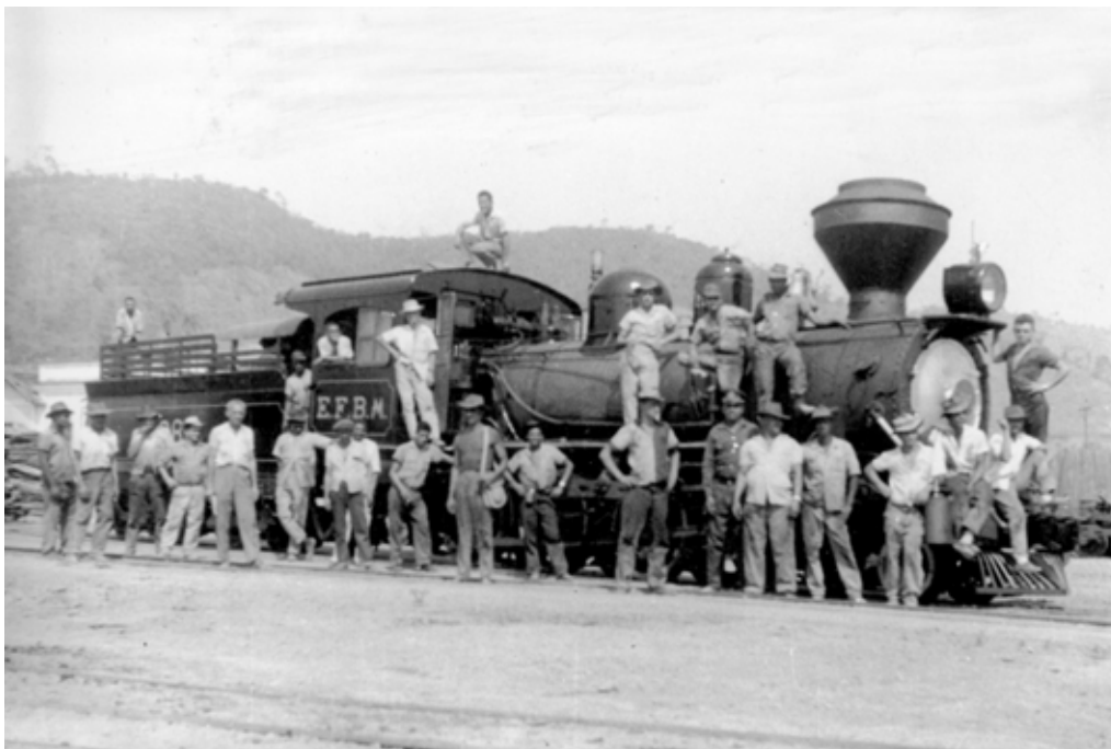
Foto11: Praça Tiradentes - Locomotiva a vapor da E.F.B.M. de fabricação americana. É interessante observar que esta foi uma das últimas locomotivas movidas a vapor, uma vez que a ferrovia foi desativada no ano de 1966, por ordem do Marechal Castelo Branco quando já dispunha de locomotivas a diesel. Teófilo Otoni. Ano: Julho de 1962. Procedência: Coleção Arysburc Batista Eleutério
